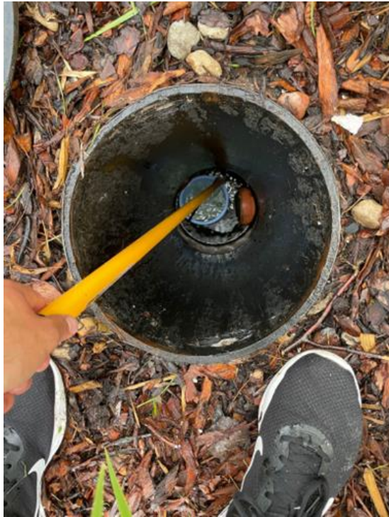
89. attēls. Bioievalkas drenāža ( Maskavas iela )
